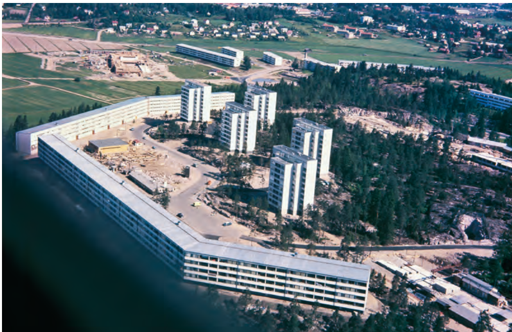
Lähiöiden rakentaminen käynnistyi monissa paikoissa 1900-luvun puolivälissä. Kuvan Helsingin Pihlajamäen alue rakennettiin pääosin vuosina 1959–1965.
